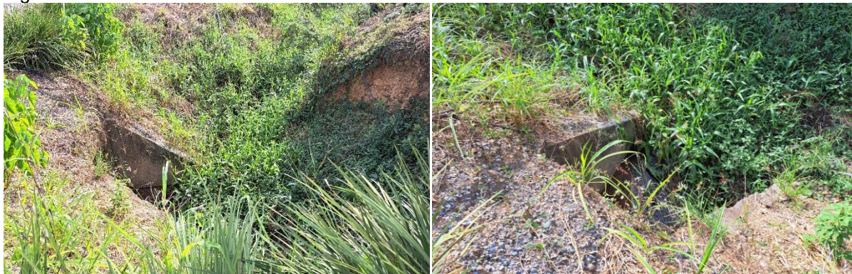
Figura 20: Entrada do trecho tubulado sob a rodovia – em 04/2024.
