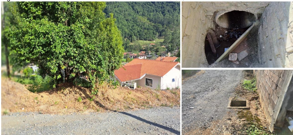
Figura 24: Entrada do trecho tubulado sob a rodovia – em 04/2024.
