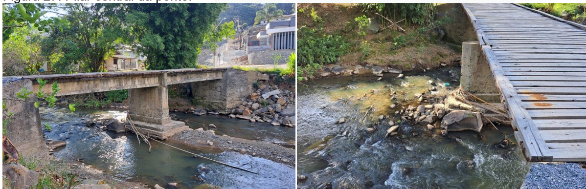
Figura 27: Pilar central da ponte.
