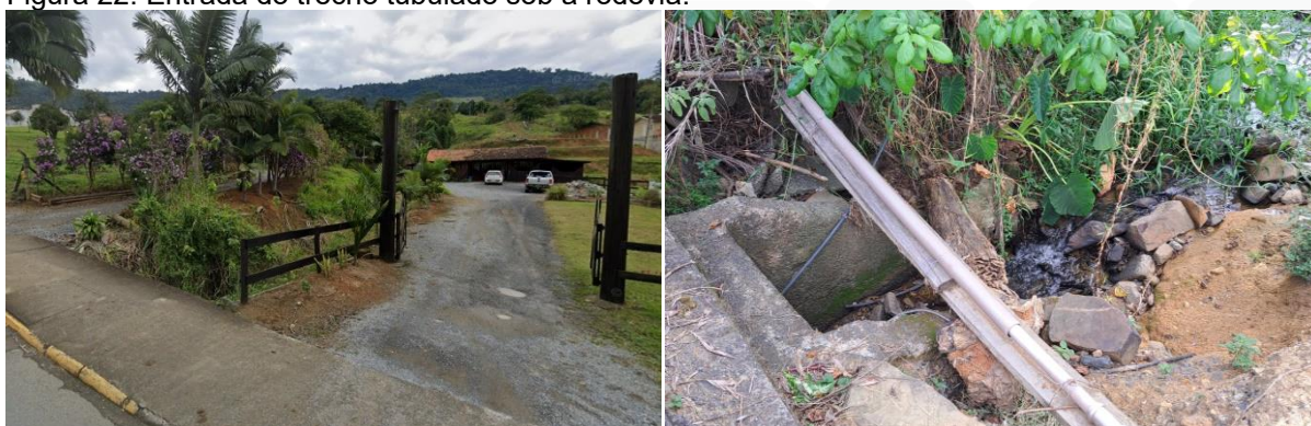
Figura 22: Entrada do trecho tubulado sob a rodovia.
